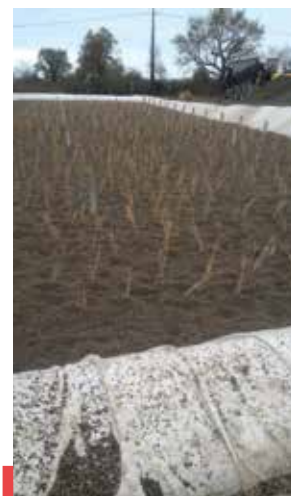
Filtre planté de roseaux dans la station d'épuration
